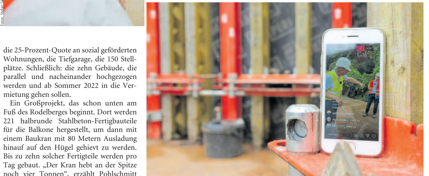
Oben: Bauunternehmer Tim Gemünden stellt die Baustelle vor. Unten: Über die sozialen Netzwerke können die Studierenden an der digitalen Baustellenbegehung teilnehmen.
