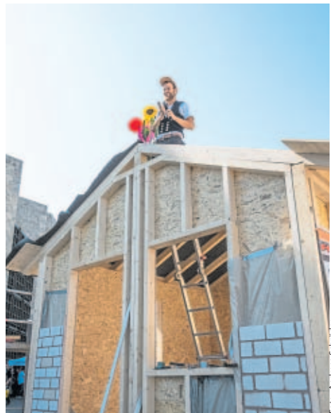
Kleines Richtfest für das Handwerkerhaus auf dem Jockel-Fuchs-Platz
