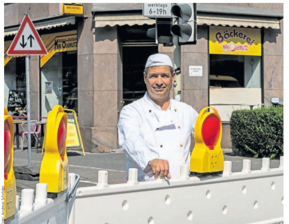
An die Bauzäune vor seinem Geschäft in der Boppstraße muss sich Bäckermeister Kai Olemutz erst noch gewöhnen. Er hofft, dass sie nicht zu viele Kunden abhalten werden
